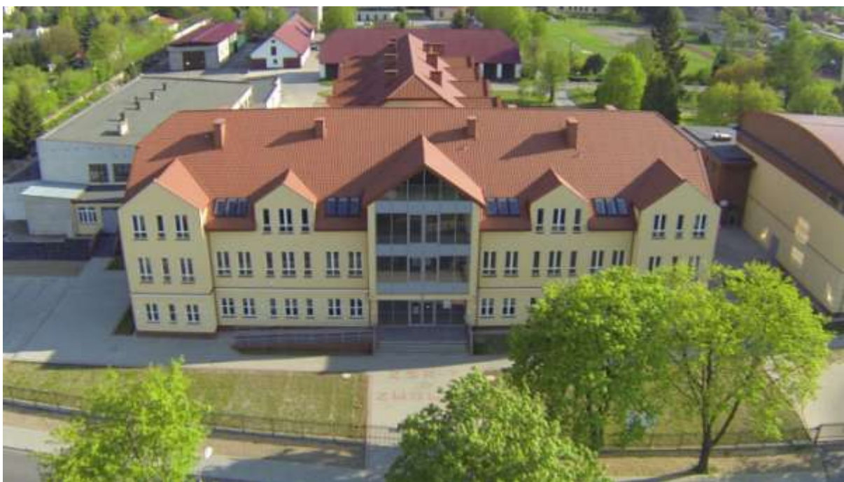
Fot. Michał Zawadzak. Nowe budynki dydaktyczne ZSR-T w Zwoleniu.
